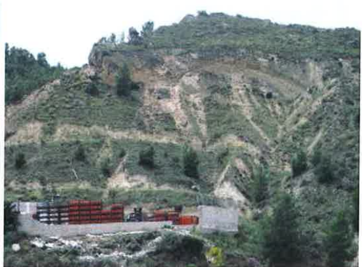
Figura 4.6: Vista de la ladera en un depósito de bombonas de gas en la carretera del pantano de Puentes. No se han identificado inestabilidades del terreno atribuibles a los terremotos del 11 de Mayo, aunque el desplome del murete de bloques de hormigón sí se atribuye a estos.
