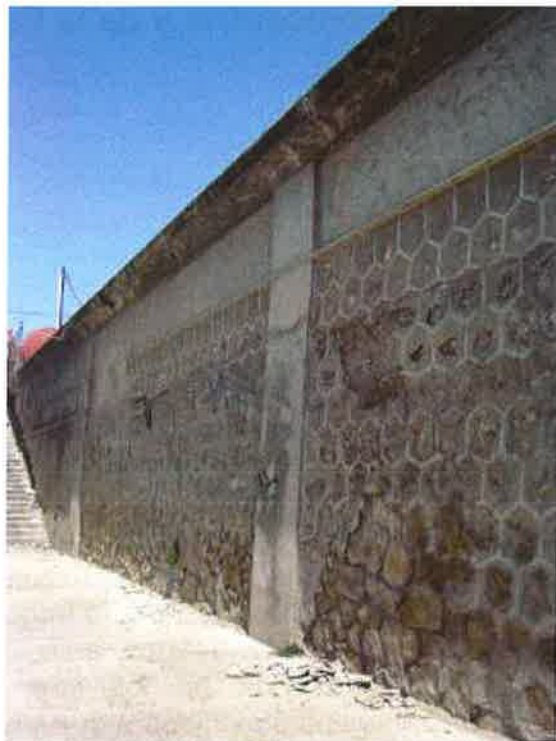
Fig. 3.1 muro de la rambla del río Guadalentín a su paso por Lorca, usado como marcador.
