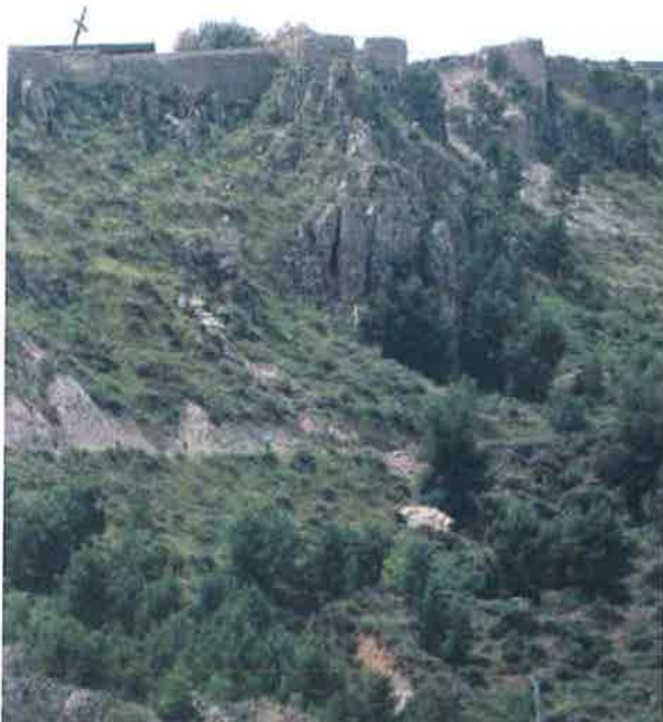
Figura 4.2.4a: Desprendimiento de un bloque rocoso de dimensiones métricas que provocó daños importantes en la carretera (ver foto 1.4b).
