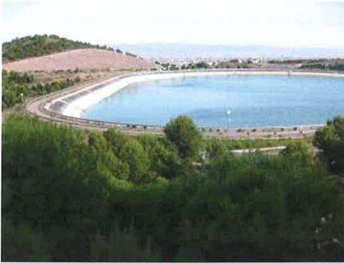
Figura 4.7: Balsa de riego localizada en las inmediaciones de los epicentros de los terremotos del 11 de mayo. No se observó ningún daño ni inestabilidades aparentes en el talud del fondo.
