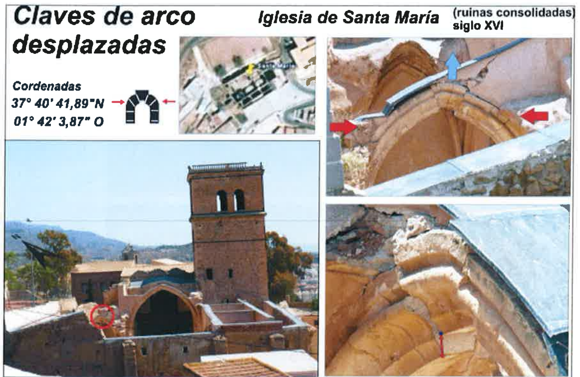
Figura 5.10 Iglesia de Santa María. Clave de arco extruida al no soportar carga vertical.
