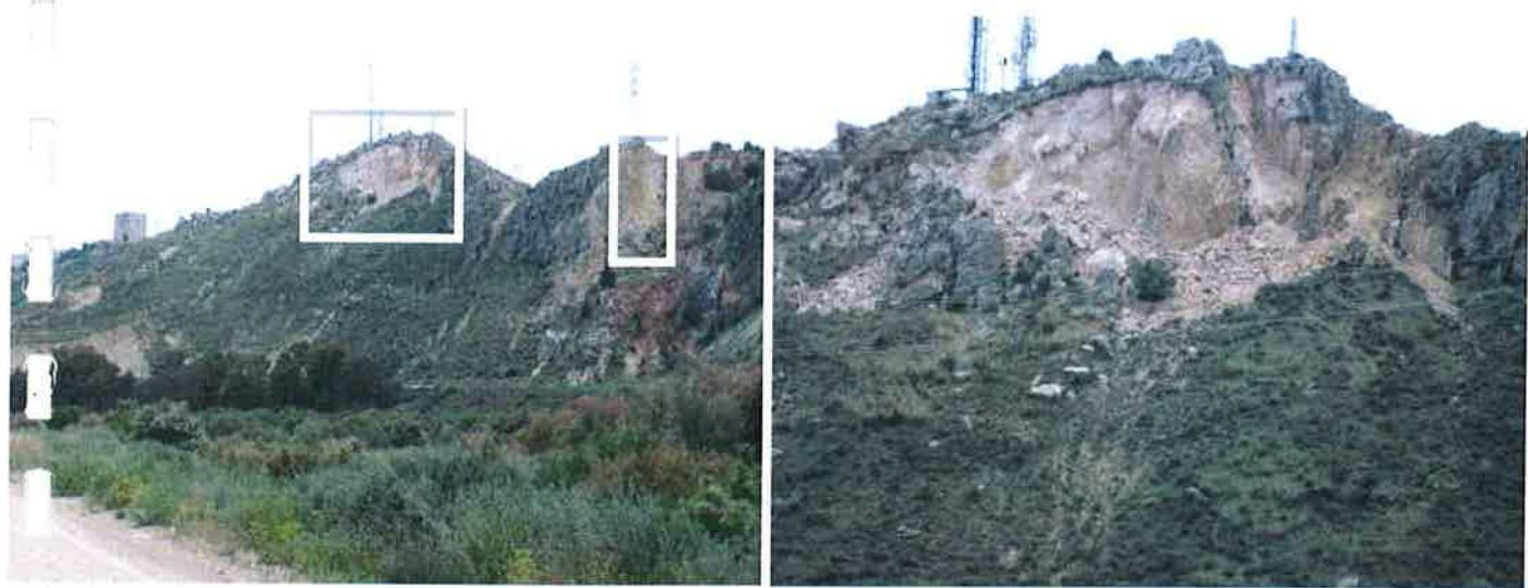
Figura 4.4.1a: Desprendimientos en la parte alta de la ladera norte de la carretera al pantano de Puentes. La atribución de su origen al terremoto del 11 de mayo se presupone. El de más hacia el oeste (a la derecha en la primera foto) se corresponde en parte con una inestabilidad previa.
