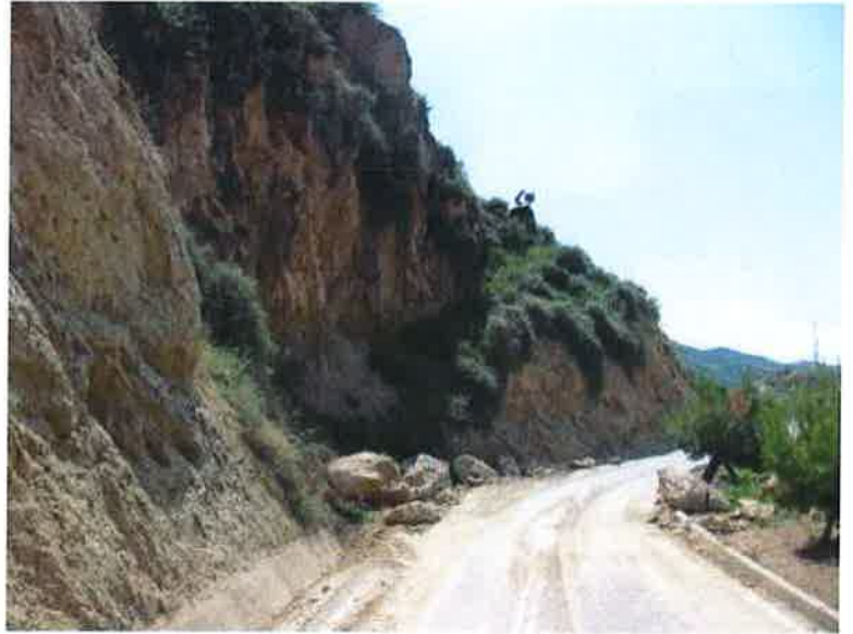
Figura 4.2.3: Desprendimiento de rocas en la carretera de subida al castillo.
