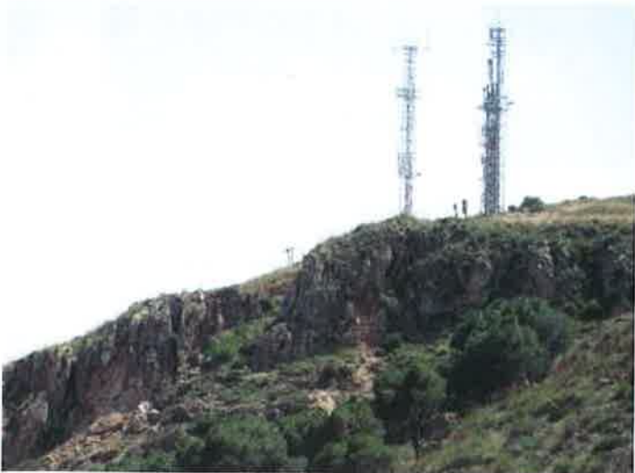
Figura 4.5: Cerro con antenas de comunicaciones situado en frente de la terminación oriental del cerro del castillo de Lorca. Se observan dos desprendimientos recientes que se atribuyen a los terremotos del 11 de mayo.
