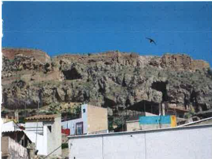
Figura 4.3.0: Vistas parciales de la falda norte del cerro del castillo de Lorca. El orden de las fotos es de oeste a este de izquierda a derecha. Solamente se han identificado dos pequeñas inestabilidades, una pequeña caída de rocas (foto núm. 2) y un desmoronamiento del muro exterior (foto núm. 3 y fig. 4.3.1). En la última foto se aprecia una visual del desprendimiento del espolón (fotos 4.2.1). Las medidas de estabilidad del macizo rocoso respondieron adecuadamente evitando mayores pérdidas y desgracias personales. Estas consisten en una malla de acero de doble diámetro cosida con bulones y una barrera dinámica. Las medidas fueron implantadas hace unos 3 años (com. pers. ayto.).
