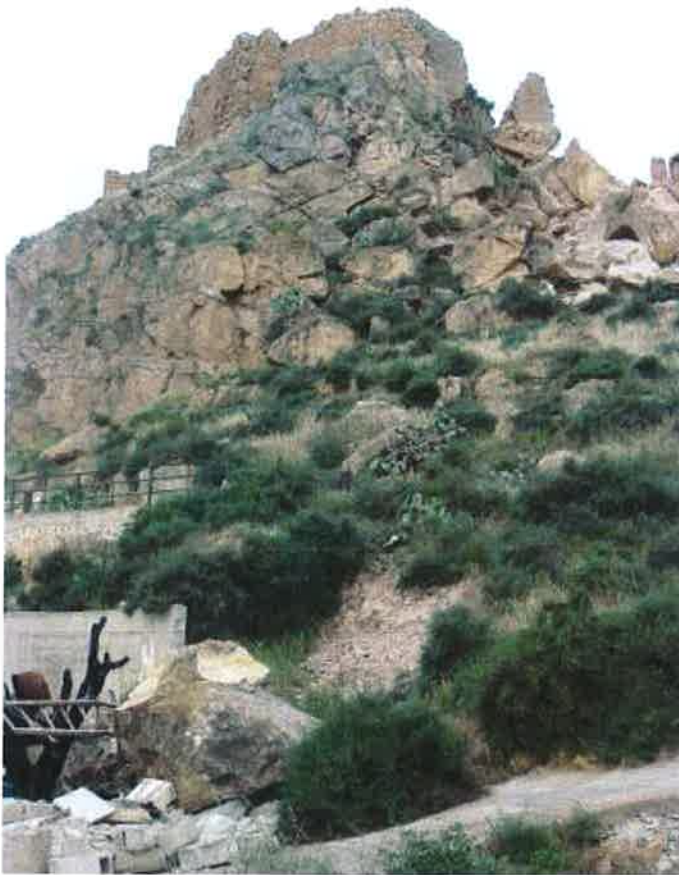
Figura 4.2.1b: Vista del lateral S del espolón del cerro del castillo y del bloque que causó la rotura de un pequeño muro. En este tramo la carretera de descenso del castillo sufrió daños moderados en el pavimento. Se observa a la izquierda la terminación lateral de la malla de contención que estabiliza el frente norte del cerro.
