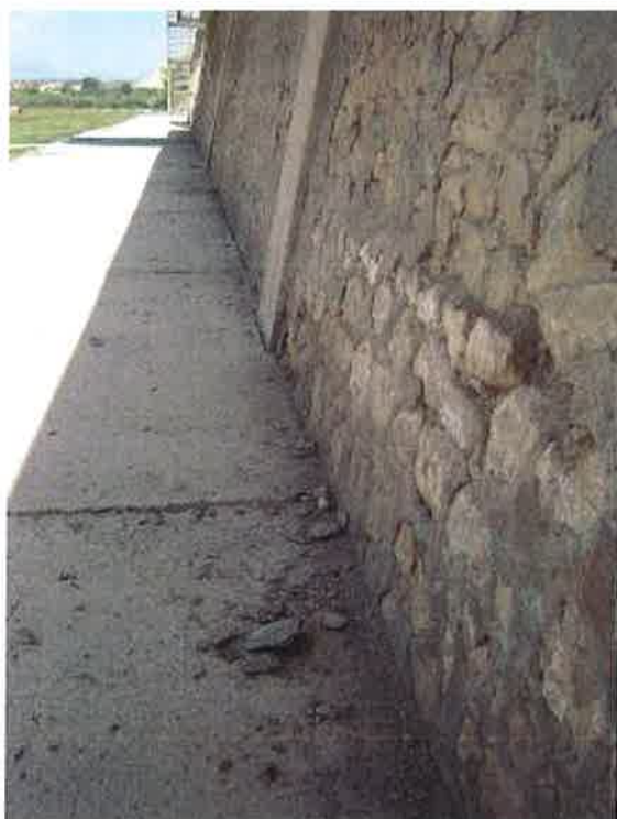
Fig. 3.2. Muro norte de la rambla del río Guadalentín.
