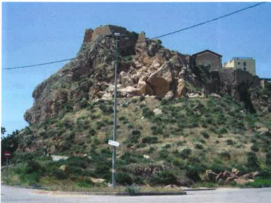
Figura 4.2.1a: Desmoronamiento parcial del espolón del cerro del Castillo (extremo más oriental del mismo). La caída de un bloque independizado provocó daños en una vivienda (ver Fig. 4.2.1c). La imagen de la derecha se corresponde con el mismo lugar y está tomada del estudio de riesgo sísmico de la ciudad de Lorca (IGME, 1992).
